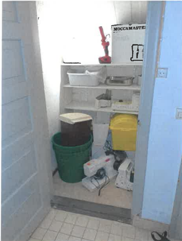
Anne Keltamäki 02.11.2023 09:46 Varasto muovimatto lattiassa, maali seinässä. Pintakosteusarvot koholla seinä- ja lattiarakenteissa.
