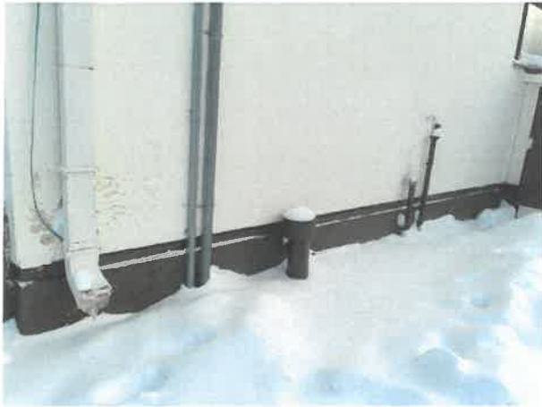
Anne Keltamäki 02.11.2023 10:04 Salaojat ja sadevesijärjestelmä tehty tälle yhdelle sivulle viime kesänä
