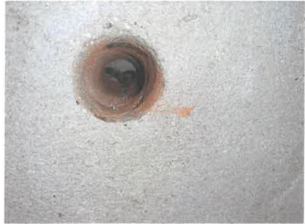
Anne Keltamäki 02.11.2023 08:56 Tutkimuspiste 2, kellarin maanpaineseinärakenne: tasoite, tiili 14 mm, ilmaväli, pikieriste, betoni
