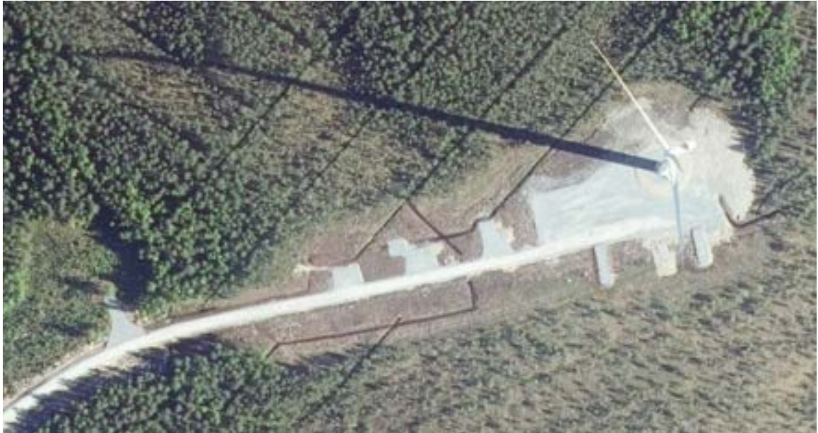
Kuva 12. Esimerkki juuri valmistuneen tuulivoimalan asennusalueesta. Ilmakuvan lähde: Maanmittauslaitos, avoimet aineistot 2022.
