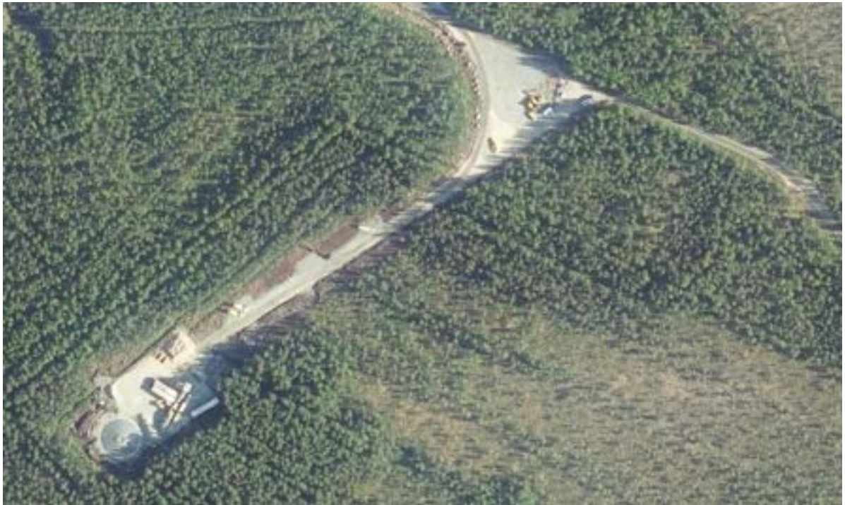
Kuva 10. Esimerkki tuulivoimalan rakennustyömaasta. Ilmakuvan lähde: Maanmittauslaitos, avoimet aineistot 2022
