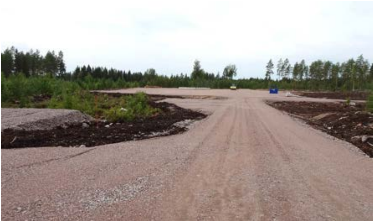
Kuva 11. Voimalan nostokentän rakennustyömaa. (Kuva J. Silvola, Ramboll)
