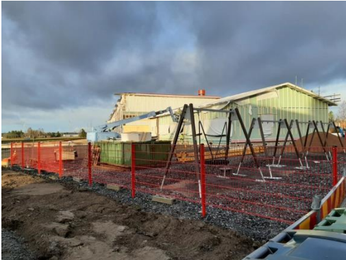
Päiväkodin rakennustyömaa marraskuussa 2021
