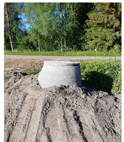
Joen rannan kaivojen suojausta.
