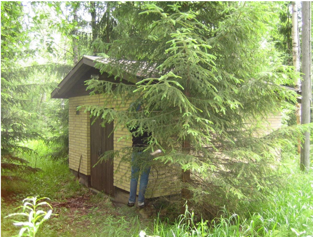
Kuva: Horon vesiosuuskunnan pumppaamorakennus Horonkylän pohjavesialueella
