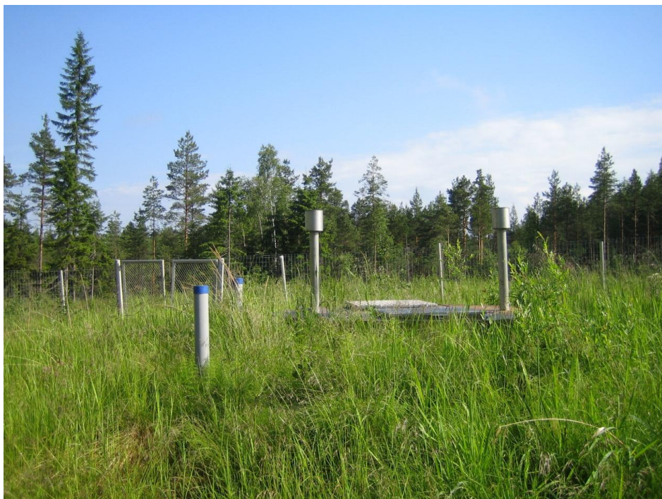
Kuva: Riipin vesiosuuskunnan vedenottamo, yksi kaivoista.
