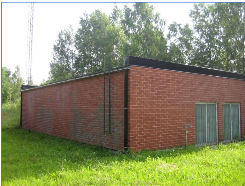
Kuva: Perälän vedenottamon rakennus Kankaanmäen pohjavesialueella
