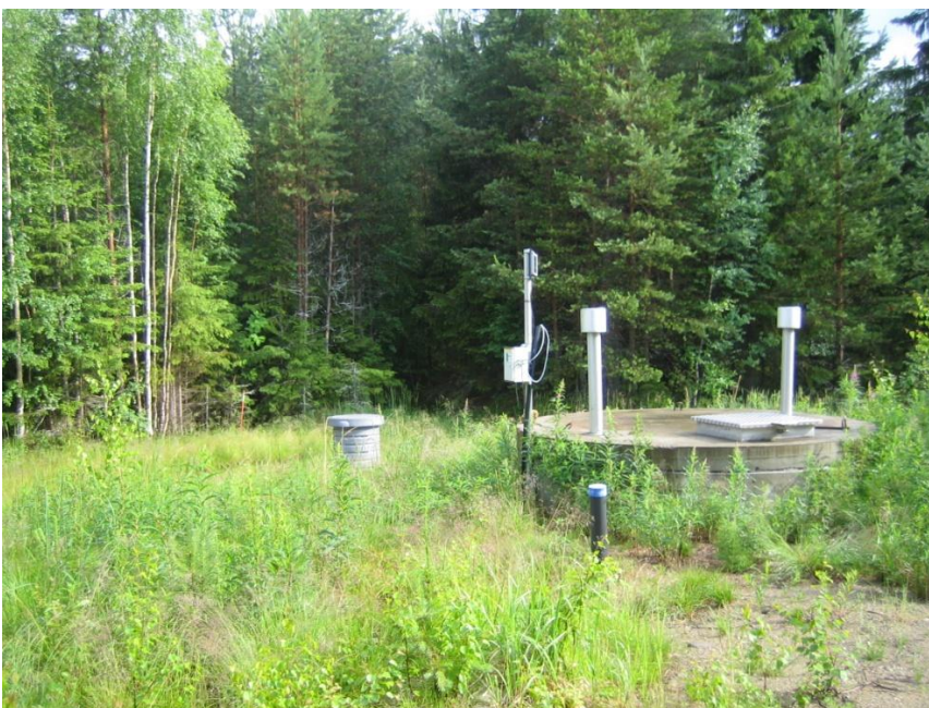
Kuva: Äystön vesiosuuskunnan kokoojakaivo
