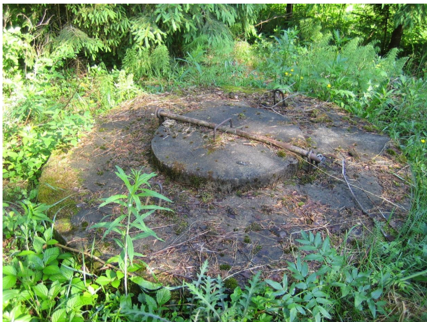
Kuva: Kankaankorven vedenottamon kokoojakaivo
